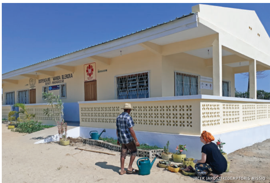
Befasy. Budynek Przychodni Zdrowia im. dr Wandy Błęskiej
