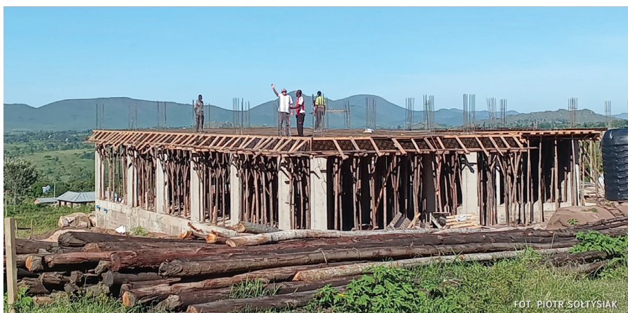
Budowa szkoły podstawowej w Butianie
